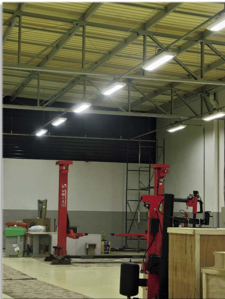
Oficinas com lâmpadas fluorescentes T5, de 54W e a 4000K, instaladas em luminárias de sobrepor com difusor de acrílico leitoso.
